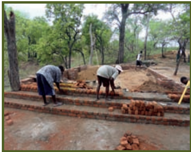
Fondations du Centre de jour pour les visiteurs
