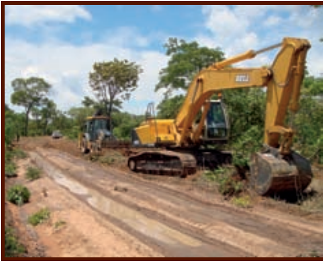
Travaux sur les routes
