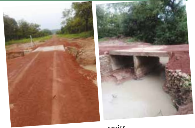
Nouveaux ponts construits
