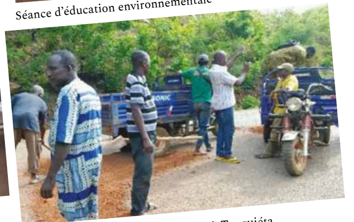
Remblayage de la voie à Tanguéta
